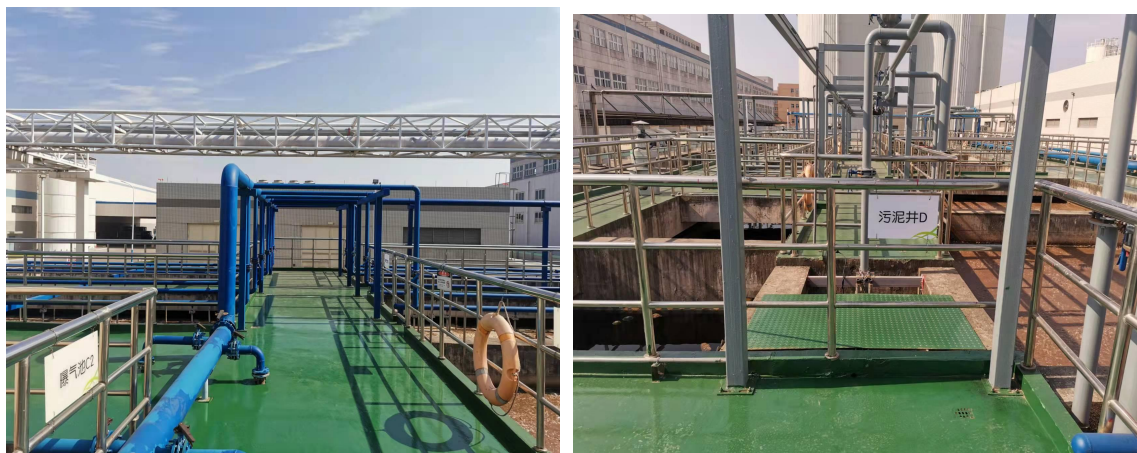
图 3-2 现状污水处理站照片
