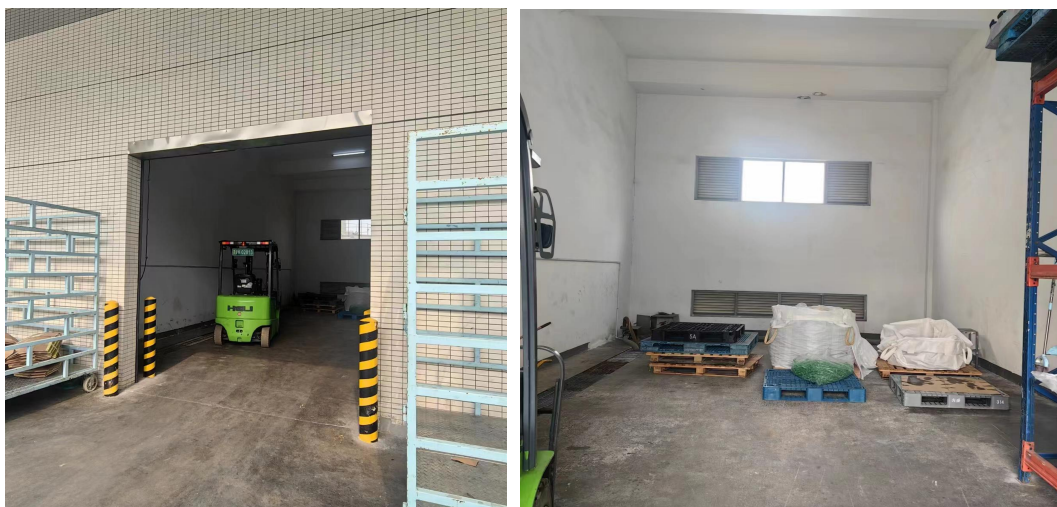
图 3-5 现状一般固废暂存间
