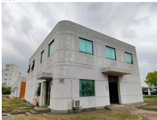
图 3-2 现状污水处理站照片
