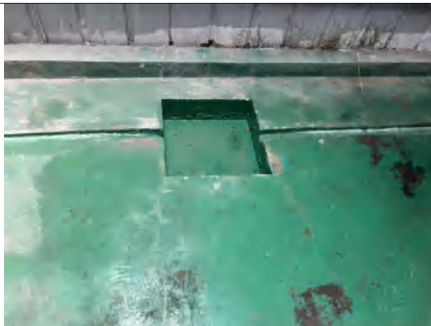
图 3-6 现状厂区各分区防渗照片
