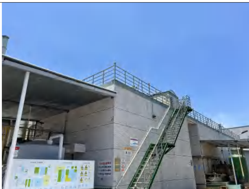
图 3-2 现状污水处理站照片
