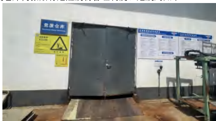
图3-3 危废仓库大门照片
