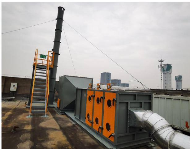
图 3-4 发泡废气处理设施照片（活性炭吸附装置 2）
