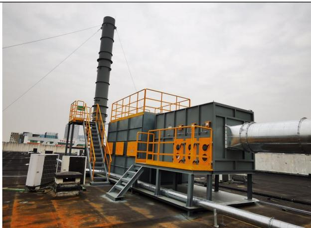
图 3-2 吸塑废气、清洁废气、小门发泡废气处理设施照片（活性炭吸附装置 1）
