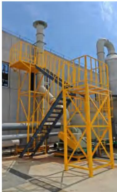
图 3-7 企业 DA004 高温纯化喷淋塔和排放口现状照片
