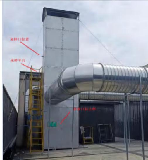
图 3-5 企业实际 DA001 粉尘除尘器和排放口现状照片 (2 套除尘装置, 2 进口 1 出口)
