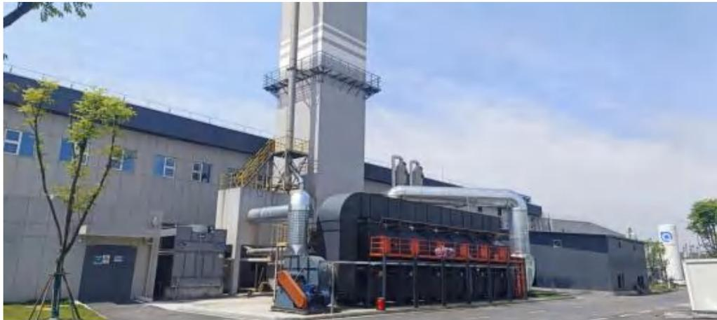
图 3-6 企业 DA003 热压吸附脱附+PTO 设备和排放口现状照片
