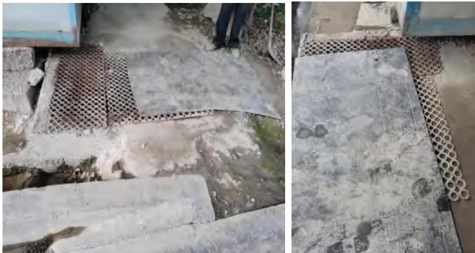
图 3-1 现状沉淀池照片
