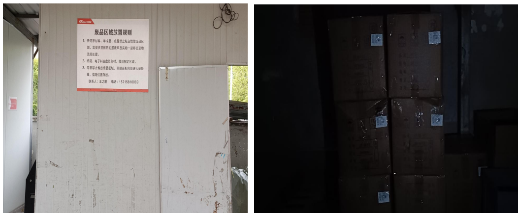
图 3-2 现状一般固废暂存间
