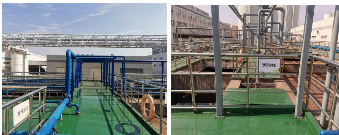
图 3-2 现状污水处理站照片
