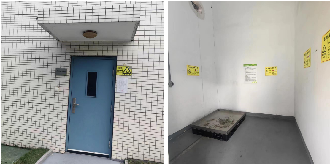
图 3-6 企业危废仓库现状照片
