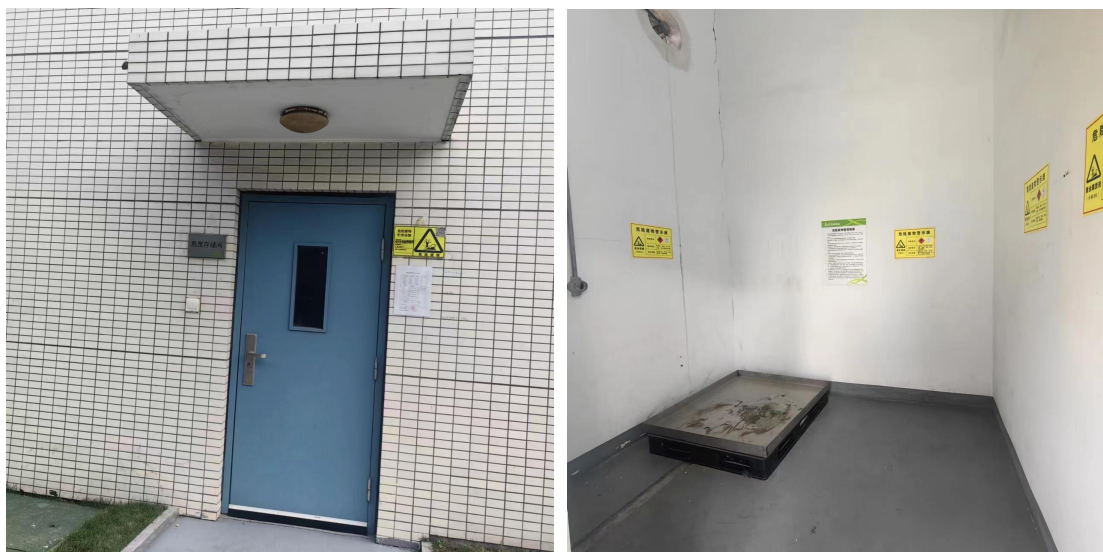
图 3-3 企业危废仓库现状照片
